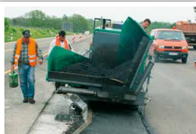
MITTELSTREIFENBEFESTIGUNG AUF AUTOBAHNEN
