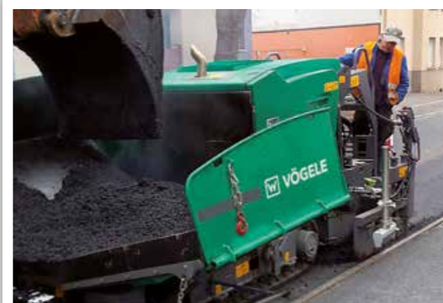
ASPHALTEINBAU ZWISCHEN STRASSENBAHNSCHIENEN
