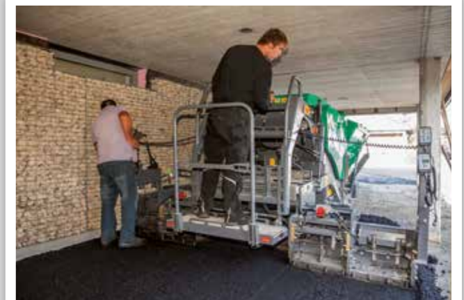
ASPHALTEINBAU IN INDUSTRIEHALLEN
