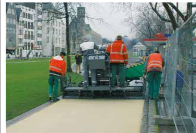
WEGEBAU IN PARKANLAGEN
