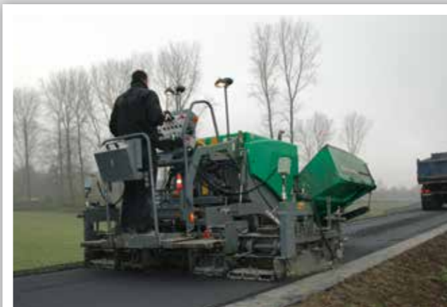
ASPHALTEINBAU AUF DÄMMEN
