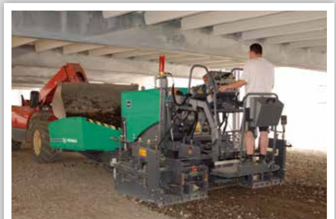
HERSTELLUNG DES UNTERBAUS FÜR PFLASTERSTEINE
