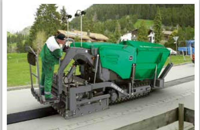
BEFÜLLEN VON KANALGRÄBEN
