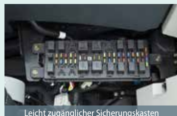
Leicht zugänglicher Sicherungskasten
